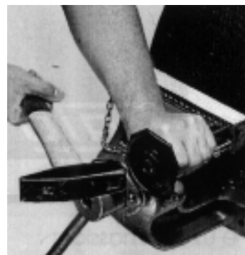
10. La reste du rivetage est à réaliser de la droite vers la gauche. Attention! Poids du marteau 500 à 800 g.
