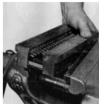
2. Installer la grafeuse PROFI 19 dans l'étau. Les trous de passage du poinçon vers l'avant. Ouvrir l'étau au maximum.
